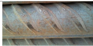
شکل ۳ ترک روی آج میلگرد قطر ۳۲
