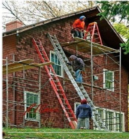
شکل ۲۸- استقرار نردبان روی جایگاه کار ممنوع
