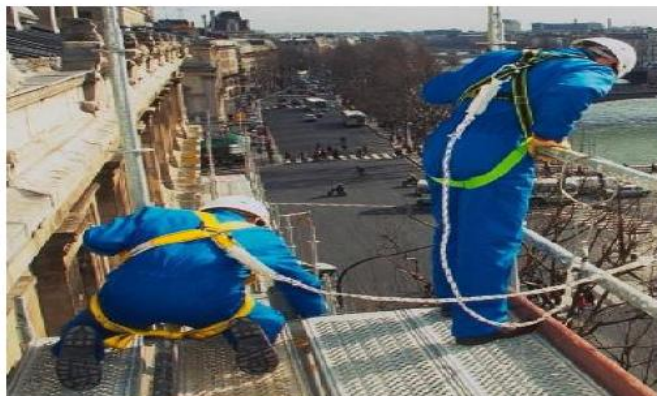
شکل ۷۸- کار بر روی سکوی کار با ابزار متوقف‌کننده
