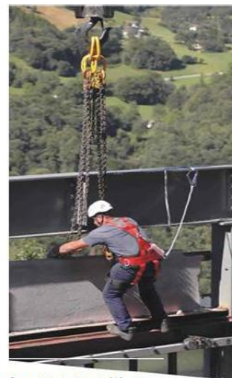
شکل ۷۵- استفاده از ابزار متوقف کننده در اجرای سازه فلزی
