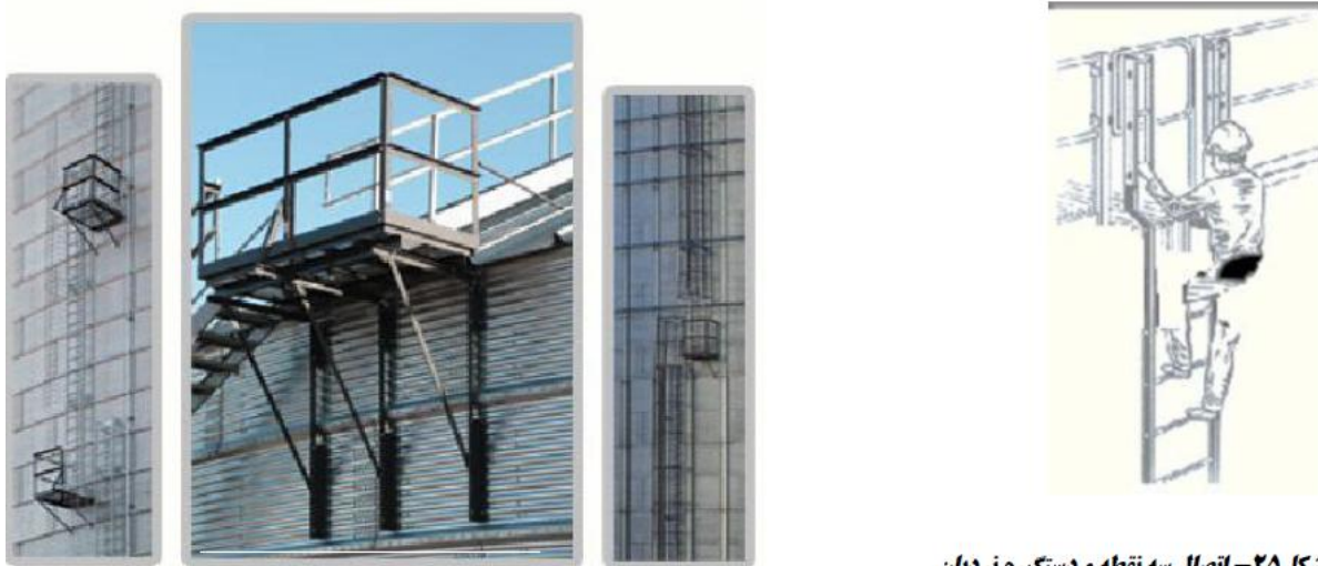
شکل ۲۴- پاگرد در نردبان ثابت
