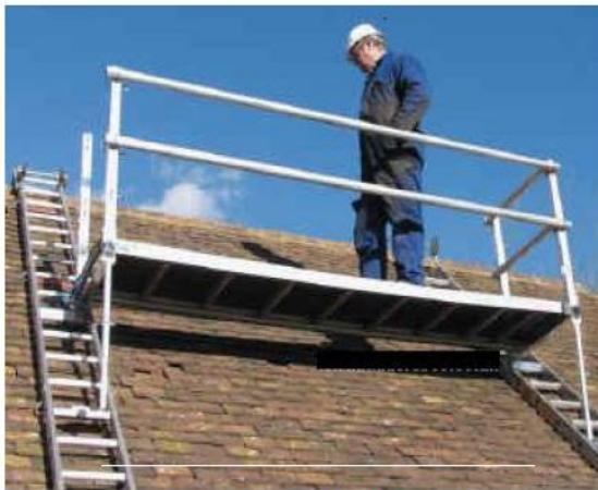
شکل ۳۰- جایگاه کار روی سطوح شیبدار
