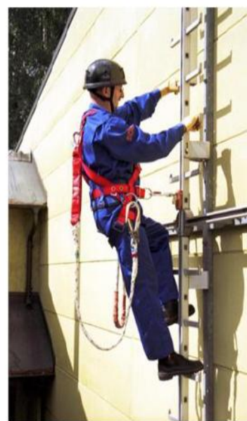
شکل ۱۱۰- سامانه متوقف کننده یا استفاده از ریل مخصوص در نردبان
