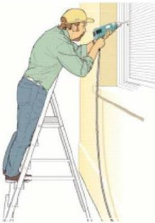
شکل ۱۰- استقرار صحیح برای کار
