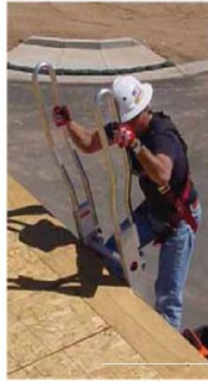
شکل ۶-۱ دستگیره نردبان ثابت
