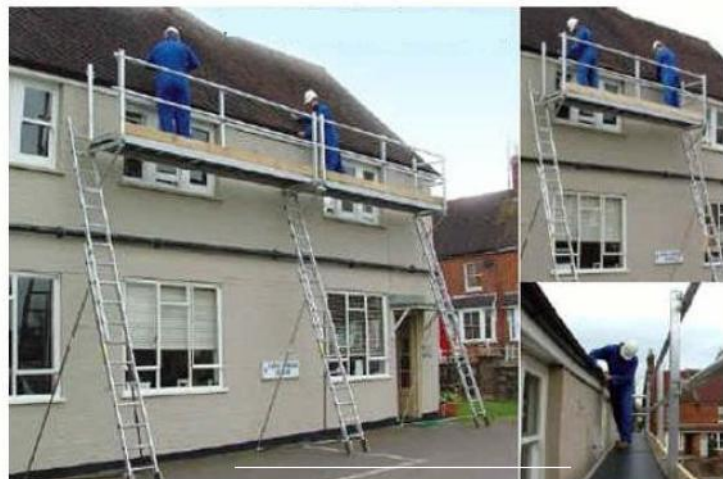
شکل ۳۲- جایگاه کار با استفاده از نردبان
